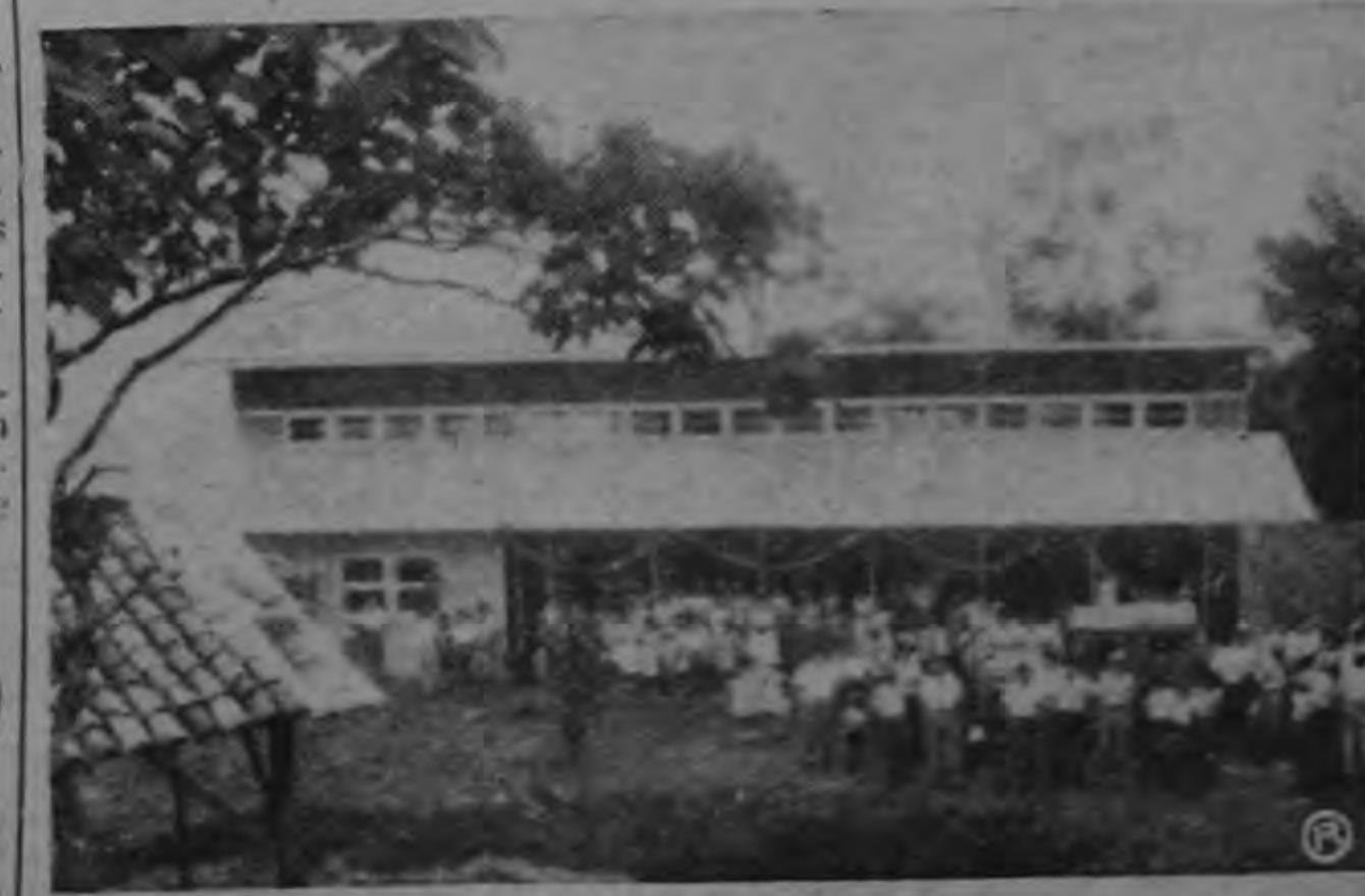
INAUGURADA LA ESCUELA DE ESTANQUILLO.— El Ministerio de Obras Públicas entregó el domingo pasado a las autoridades escolares la moderna escuela de Estanquillo. Esta es otra de las escuelas prefabricadas que se producen en los Talleres del MOP. Nótese en primer término el viejo galerón de la escuela.
